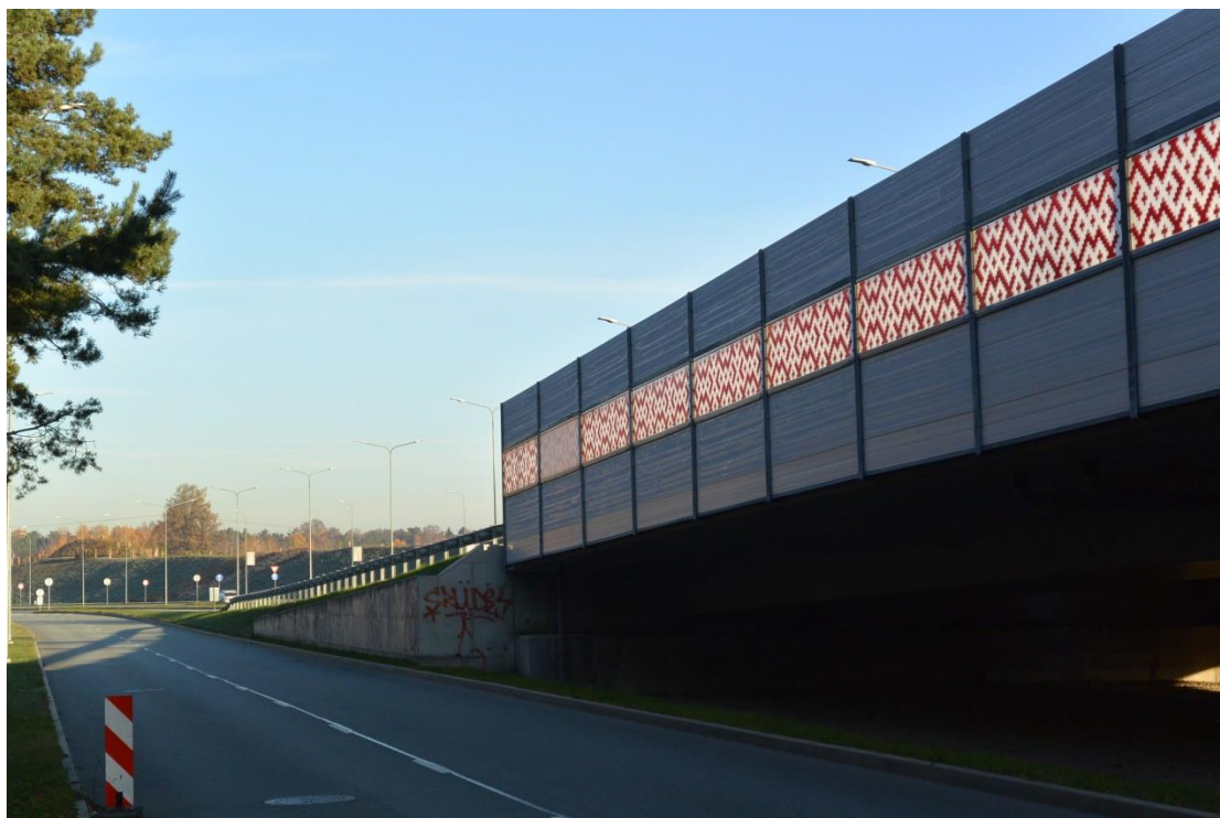
3.14.9. attēls. Trokšņa barjera uz pārvada pār Gaujas ielu
