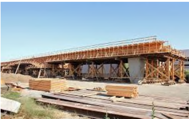
1.6.30. attēls. Laiduma konstrukcijas betonēšana uz vietas veidņiem
