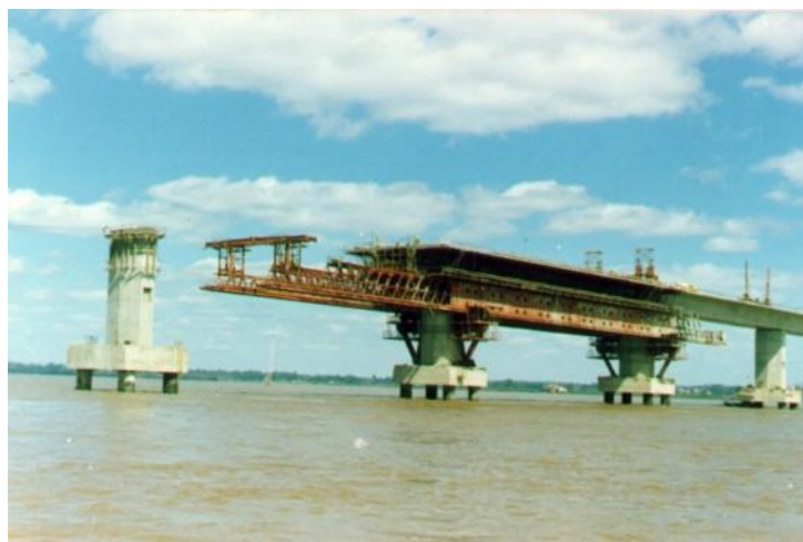
1.6.32. attēls. Laiduma konstrukcijas betonēšana uz slīdošajiem veidņiem
