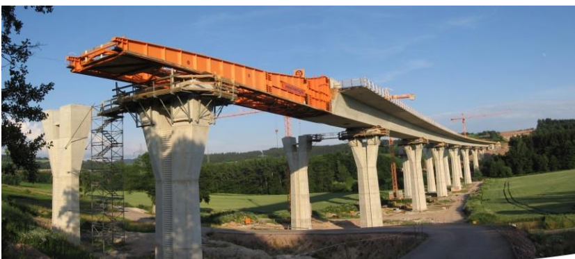
1.6.34. attēls. Laiduma konstrukcijas uzbīdīšana
