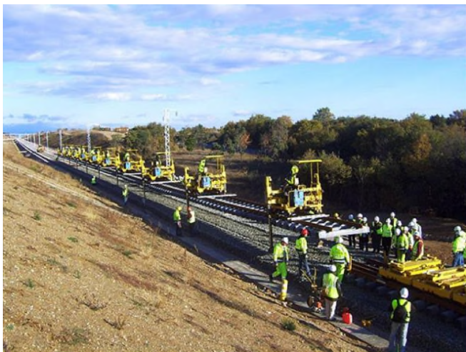
1.6.28. attēls. Sliežu režģu izbūve ar pašgājējiekārtas kompleksu
